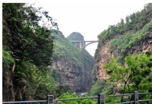
跨越峽谷上方的大橋
