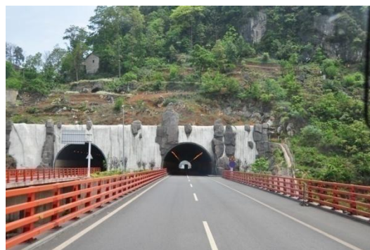
高速公路有許多隧道
